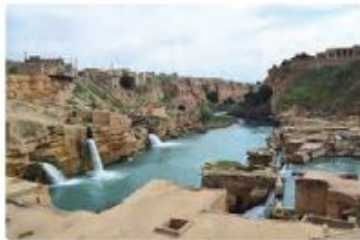
سازه‌های آبی نوسنر که از دوران هخامنشیان تا ساسانیان، جهت بهره‌گیری بیشتر از آب ساخته شده‌اند.
