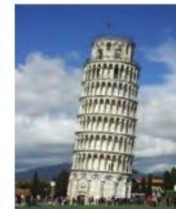
شکل ۱-۶ نشست نامتقارن بی در برج پیزا
