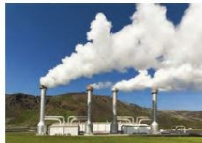
شکل ۴-۱۱ نیروگاه زمین گرمایی مشکین شهر - اردبیل
