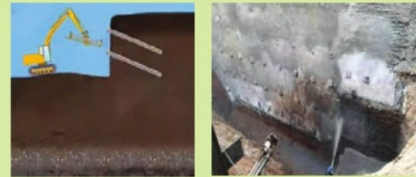
پایدارسازی شیب به روش میخ کوبی
