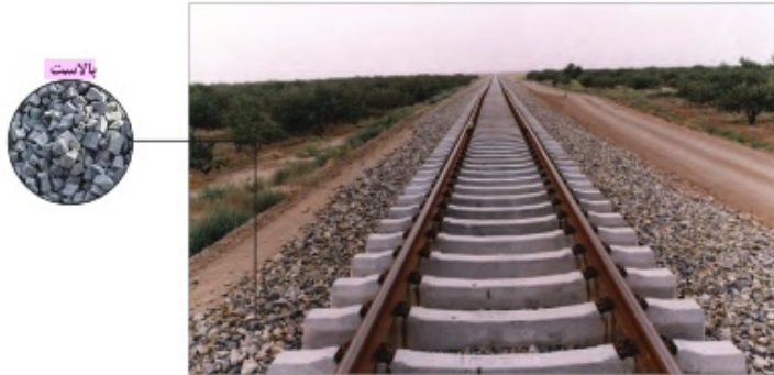
شکل ۴-۱۱- بالاست در زیرسازی جاده ریلی
