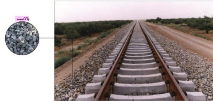
شکل ۴-۱۳- بالاست در زیرسازی جاده ریلی
