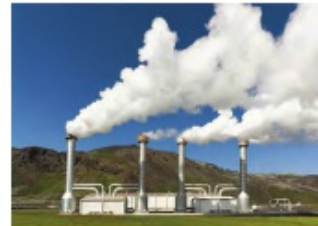
شکل ۶-۱۱. نیروگاه زمین گرمایی مشکین شهر - اردبیل
