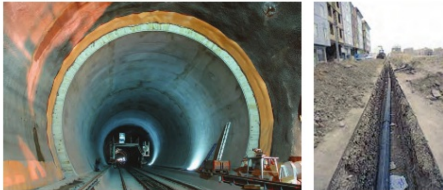
ب) پوشش داخلی تونل به وسیله قطعات بتن
