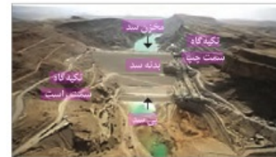
شکل ۵-۴- نمایی از بخش‌های مختلف یک سد
