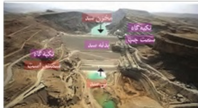
شکل ۴-۵- نمای از بخش‌های مختلف یک سد
