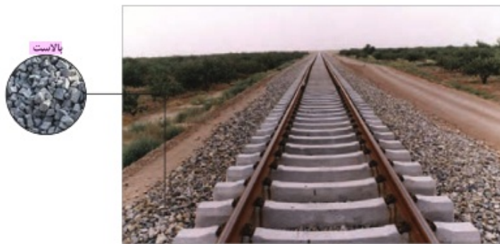
شکل ۴-۱۳. بالاست در زیرسازی جاده ریلی
