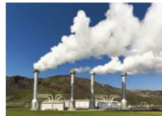
شکل ۶-۱۱- نیروگاه زمین گرمایی مشکین شهر - اردبیل
