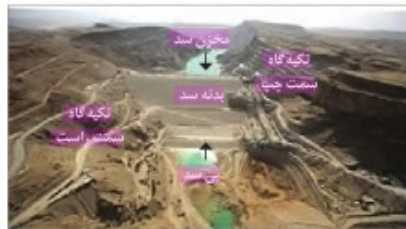
شکل ۴-۵- نمایی از بخش‌های مختلف یک سد
