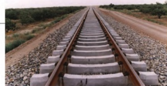
شکل ۲۳-۴. بالاست استفاده‌شده در زیرسازی جاده ریل
