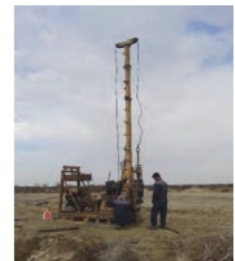
شکل ۶-۳ حفز گمانه اکتشافی توسط دستگاه حفاری
