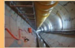
تونل انتقال آب (تونل کانی سیب - پیرانشهر)
