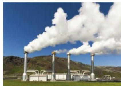
شکل ۳-۹. نیروگاه زمین گرمایی مشکین شهر - اردبیل
