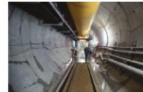
ب) پوشش‌های بتنی در مترو
