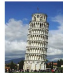
شکل ۶-۴ نشست نامتقارن پی در برج پیزا
