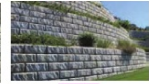
لب (دیوار حائل)
