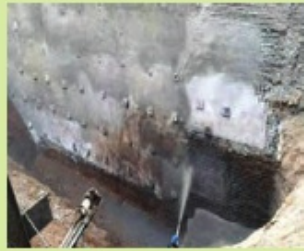
پایدارسازی شیب به روش میخ کوبی
