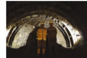
ب) نحوه اجرای پوشش‌های بتنی در فضاهای زیرزمینی
