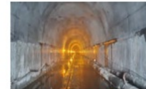
الف) پوشش‌های بتنی در معارها
