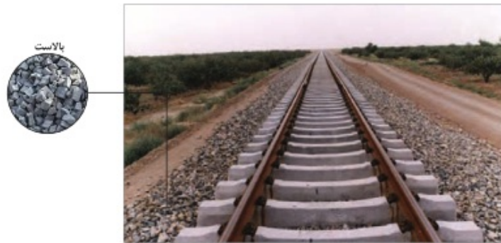
شکل ۴-۱۱- بالاست در زیرسازی جاده ریلی
