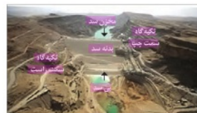
شکل ۴-۵: نمایی از بخش های مختلف یک سد
