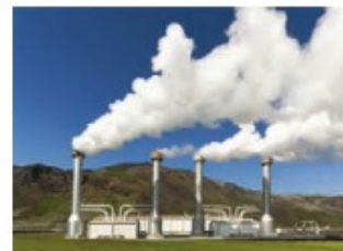
شکل ۶-۱۱. نیروگاه زمین گرمایی مشکین شهر - اردبیل
