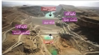
شکل ۴-۵. نمای از بخش‌های مختلف یک سد
