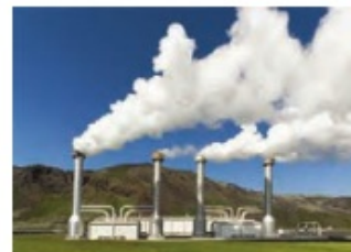
شکل ۶-۱۱. نیروگاه زمین گرمایی مشکین شهر - اردبیل
